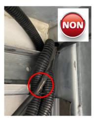
Protéger les gaines et les câbles pour et le positionner de manière à qu'ils ne viennent pas en contacte avec les roulettes ou plus généralement de la porte.
