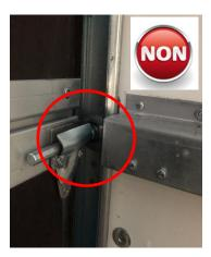
En cas d'utilisation d'un verrouillage centralisé, il faut impérativement rendre le système de pilotage de la porte inactif si celui-ci est en position fermée.
